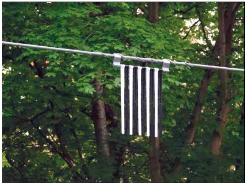
Abbildung 5: Beispiel einer Bewimpelung mit sogenannten Vogelschutzfahnen entlang der Strecke 9432 südlich der Elzmündung (Foto: CHRISTIAN HARMS)
