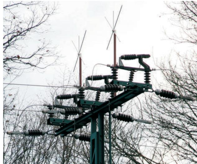
Abb. 7: Masten mit Schalter auf dem Mastkopf dürfen nicht mehr errichtet werden. Bei alten Masten dieses Typs sind Andreaskreuze (hier im Mastschalter) zulässig.
