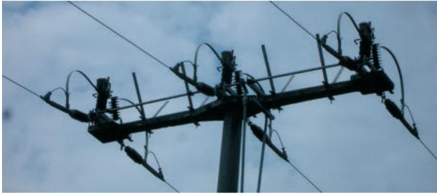
Abb. 4: Untauglich: V-förmige Vogelabweiser (hier zwischen den Schalterelementen)
