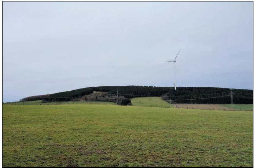
Abbildung 1: Windkraftanlage (WEA 1) am Windsberg. Links der Uhubrutplatz
