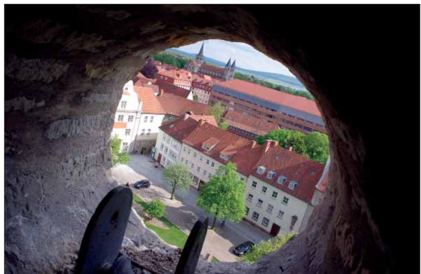
Abbildung 2: Blick aus der Öffnung des Dachbodens im Westwerk des Hildesheimer Domes. In einem Nistkasten für Turmfalken vor dieser Öffnung brüteten Uhus in den Jahren 2014 und 2015 (Foto: EDMUND DEPPE).
